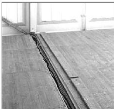
System-Kassettenfußboden mit integriertem Kabelkanal
