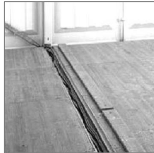
System-Kassettenfußboden mit integriertem Kabelkanal
